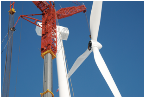
Stromversorgung für Windkraftanlagen
