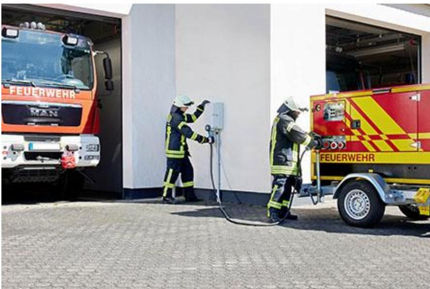
*Foto (MENNEKES): Einsatzkräfte der Feuerwehr verbinden einen Ersatzstromerzeuger mit dem zu versorgenden Gebäude. Stecker, Kupplung, Anbausteckdosen und Wandgerätestecker von MENNEKES*
