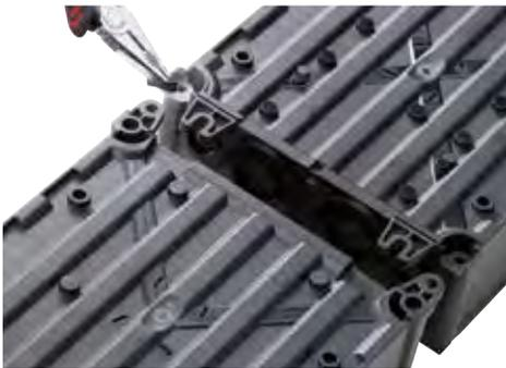
Kombizange an den dünnen Ausbruchkanten ansetzen und die vorgestanzten Ausbruchkanten mit der Kombizange herausbrechen.
